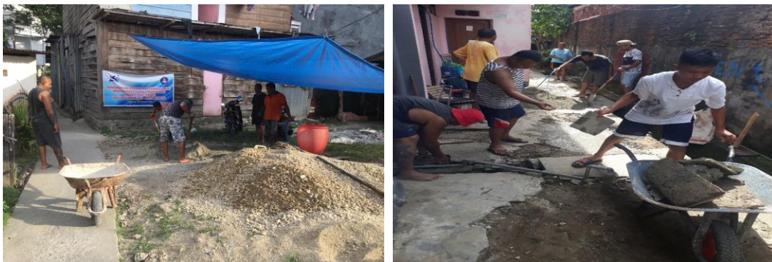
Gambar 2. Pelaksanaan Pekerjaan Jalan dan Drainase Lingkungan.
